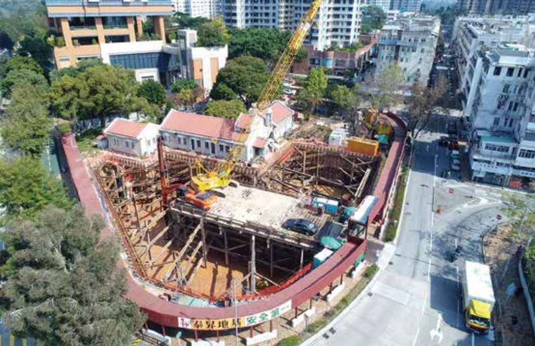
堂區擴建工程進行中
