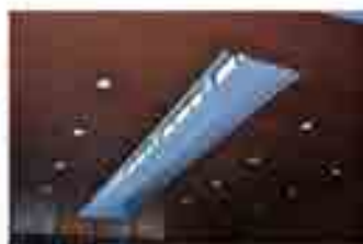
聖所及中央通廊上的天光。 採光及採風方法(窗戶以電動開關)
